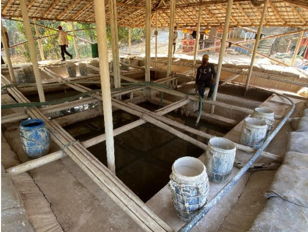
Lime dosing ponds
